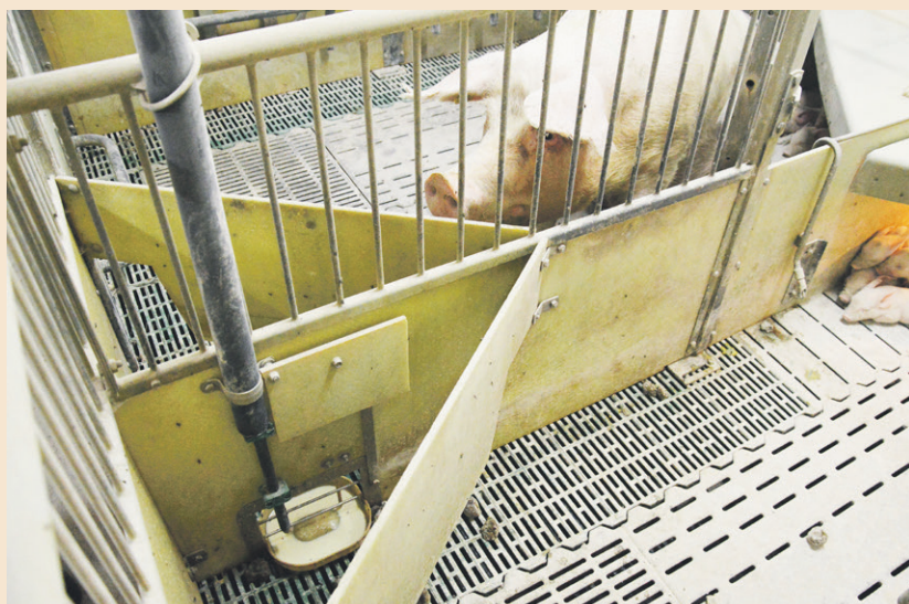
■ Når 10 søer har faret i en stald, sættes anlægget i gang og anlægget styrer derefter selv forbruget.
